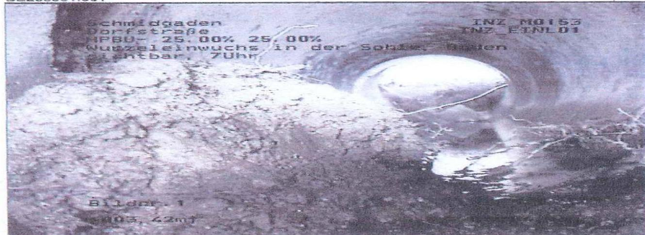
HPBU- : Wurzeleinwuchs in der Sohle, Boden sichtbar, 7Uhr 25.00 %
