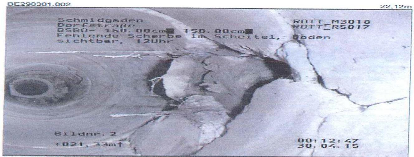
BSBO- : Fehlende Scherbe im Scheitel, Boden sichtbar, 12Uhr 150.00 cm<sup>2</sup>
