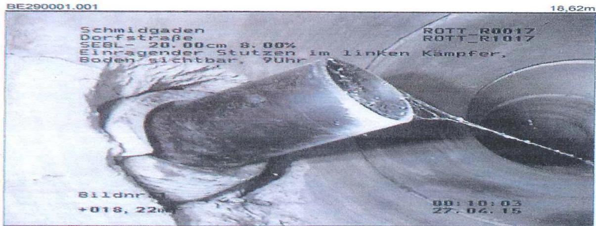
SEBL - : Einragender Stutzen im linken Kämpfer, Boden sichtbar, 9Uhr 20.00 cm, 8.00%
