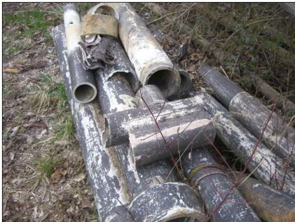
ausgewechselte, defekte Asbestzementrohre
