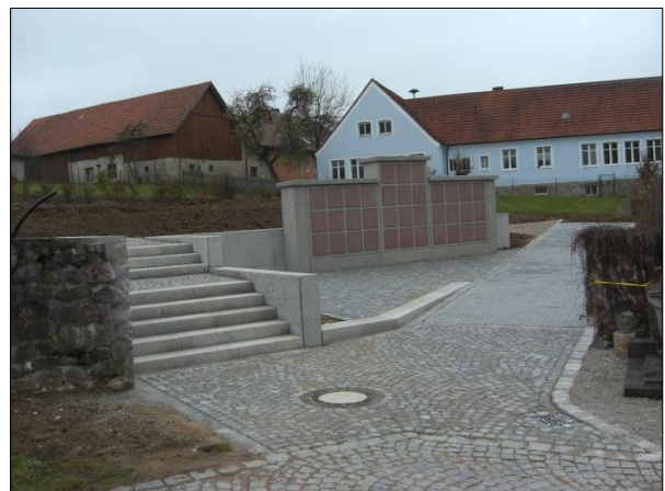
Errichtung Urnenvorplatz und Urnenwand am Friedhof Schmidgaden, Oktober 2012
