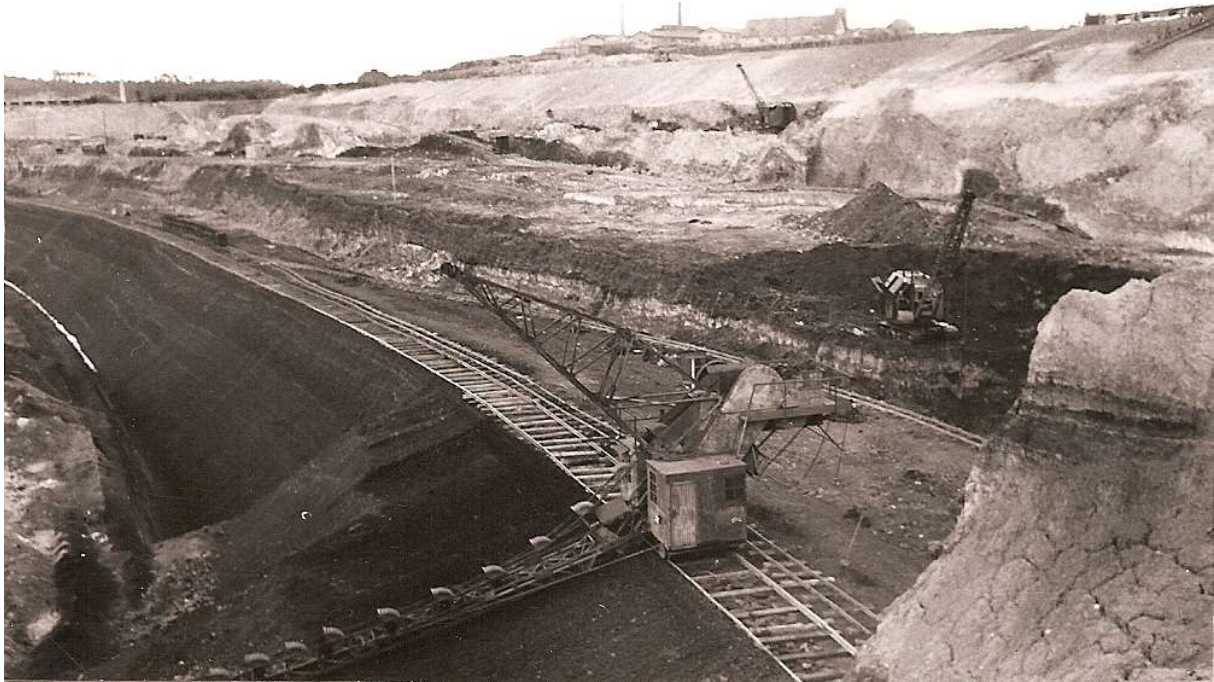
Grube Buchtal: Eimerkettenbagger und Seilbagger im Einsatz
